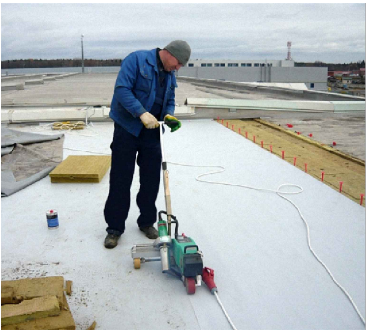
Укладання ПВХ мембрани
