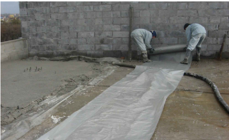
Укладання пароізоляції
