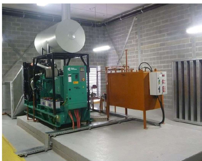
Рисунок 1.3 - Розташування дизельного генератора всередині сховища
