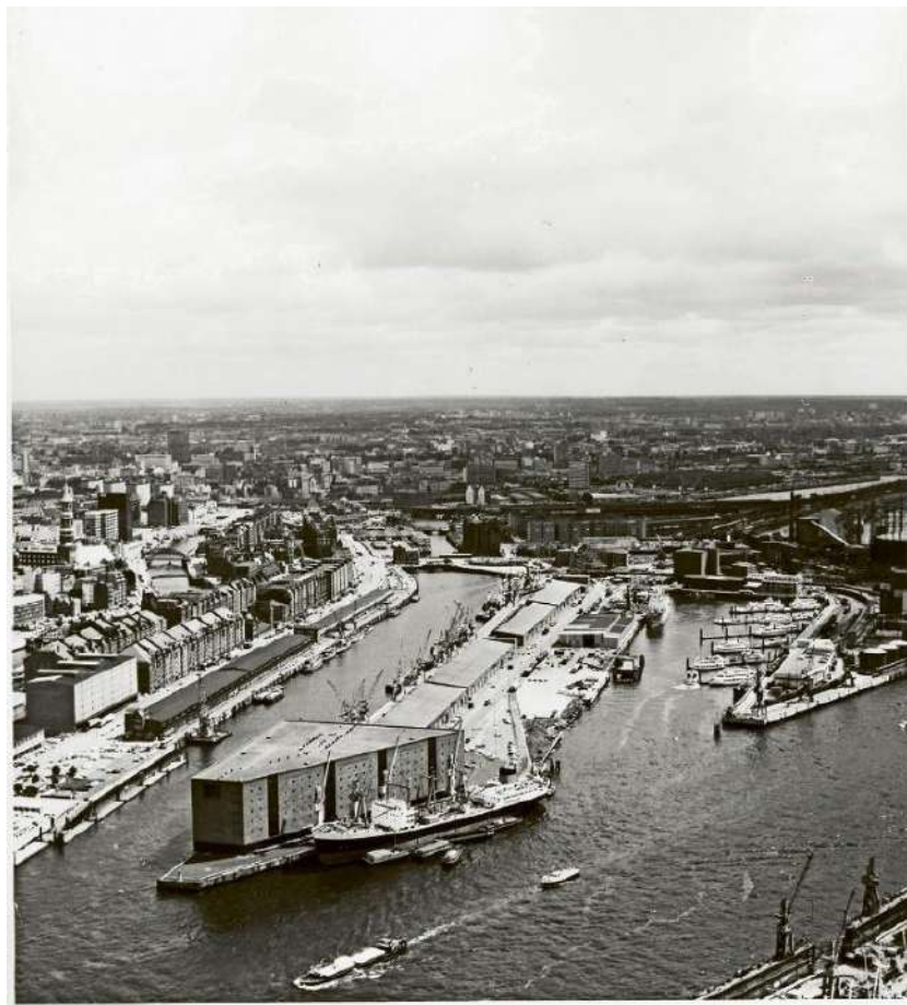
Рисунок 2.3 – Вигляд на складські будівлі до початку реконструкції
