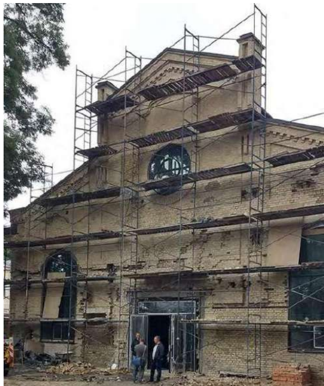
Рисунок 2.26 – Корпус №5 до реконструкції
