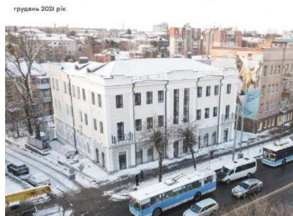
Рисунок 2.23 – Будівля після реконструкції
