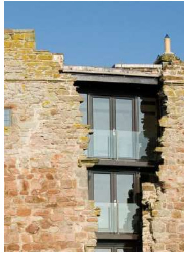
Рисунок 2.7 – Скляний фасад в тріщині вежі
