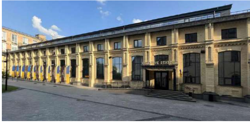
Рисунок 2.29 – Корпус №7 після реконструкції
