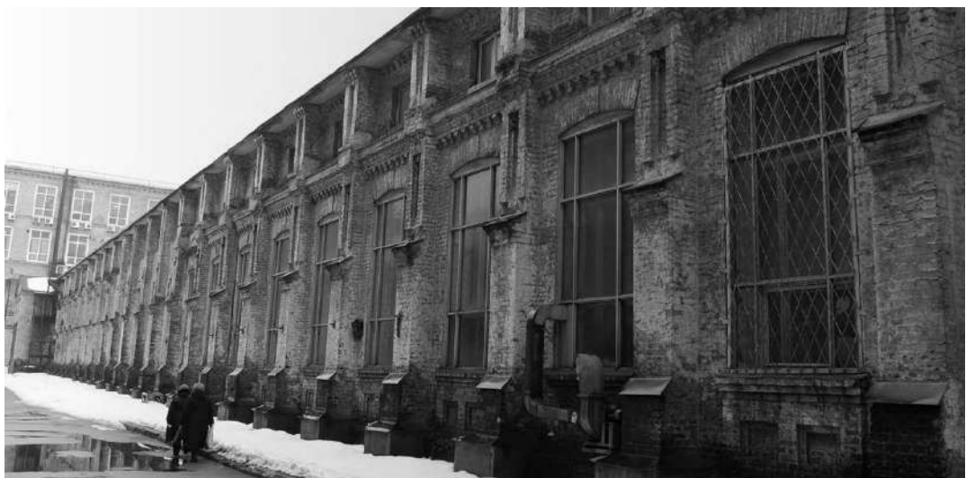
Рисунок 2.28 – Корпус №7 до реконструкції
