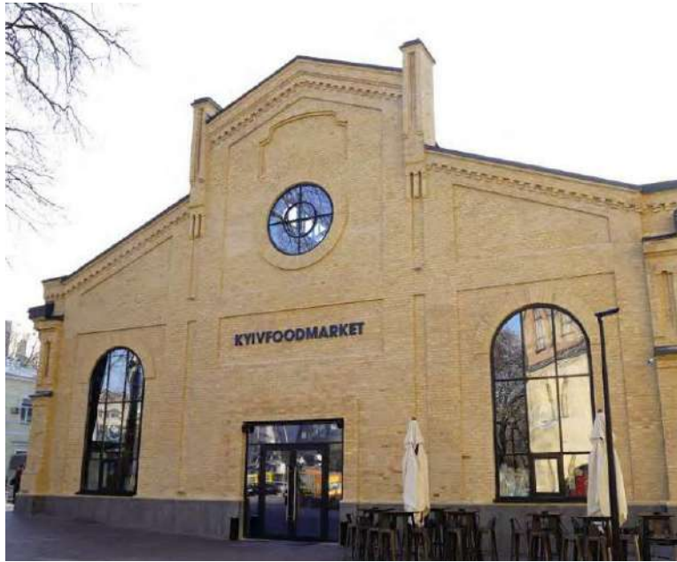
Рисунок 2.27 – Корпус №5 після реконструкції
