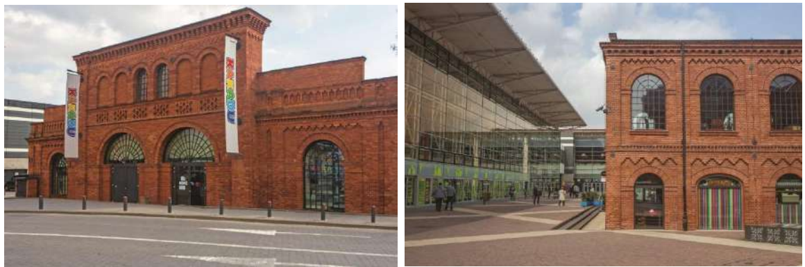
Рисунок 2.12 – Будівля після реконструкції
