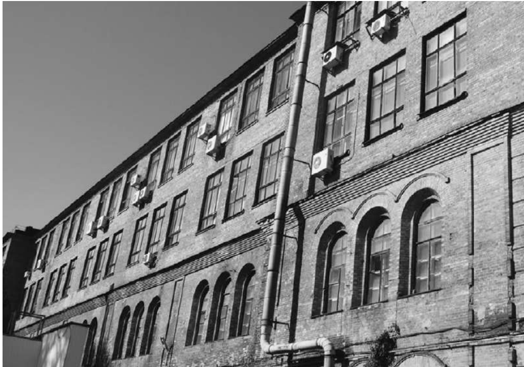
Рисунок 2.24 – Корпус №1 до реконструкції
