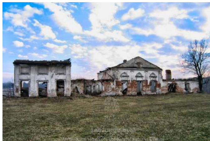
Рисунок 4.6 – Сучасний стан будівлі (парадний вхід)
