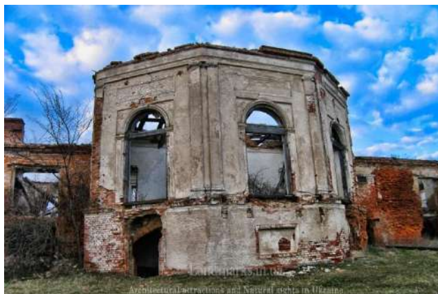
Рисунок 4.6 – Сучасний стан будівлі (овальна зала)
