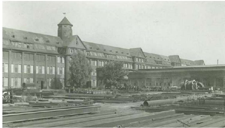
Рисунок 2.9 – Будівля заводу до реконструкції
