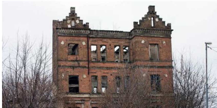
Рисунок 2.19 – Головний фасад будівлі до реконструкції
