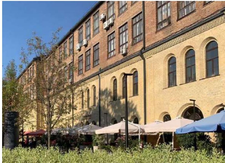
Рисунок 2.25 – Корпус №1 до реконструкції
