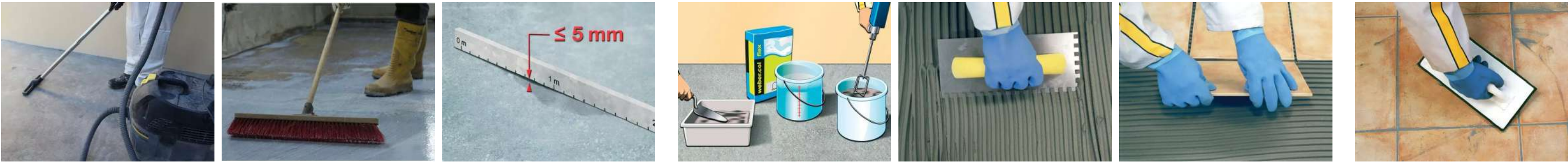
1. Підготовка основи: очищення основи, грунтування основи, перевірка рівності основи
