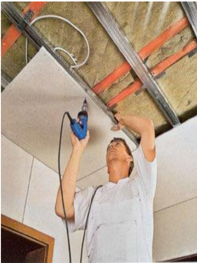
Монтаж каркасу до стелі
