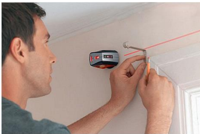
Рисунок 4.14 – Розмітка рівнем
