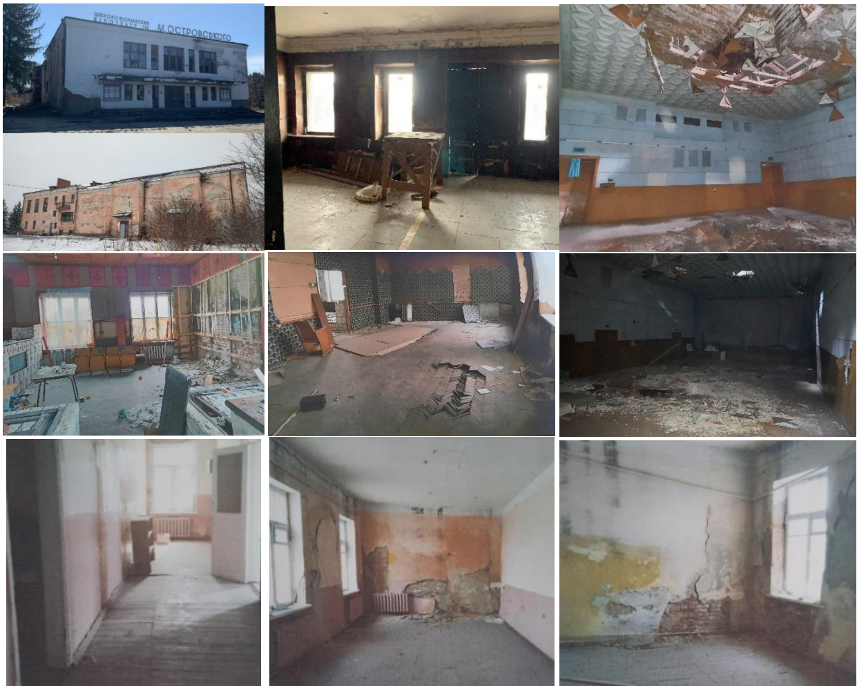
Рисунок 4.13 – Існуючий стан екстер'єру та інтер'єру будівлі
