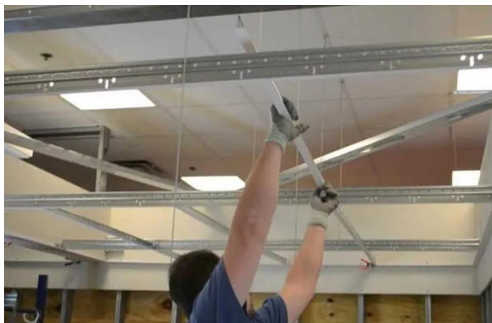
Рисунок 4.9 – Монтаж плит «Арстронг»
