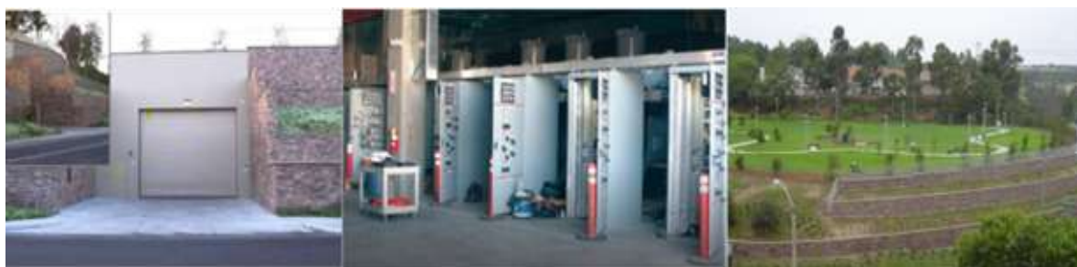
Рисунок 3.2 Підземна підстанція Park Above США [25]
