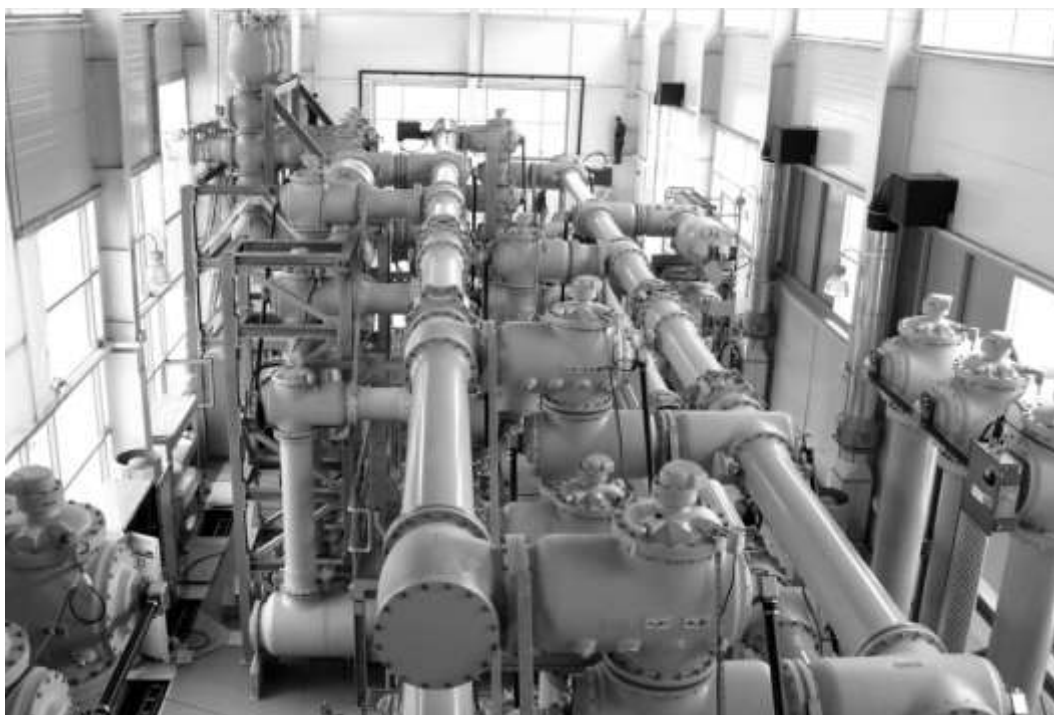
Рисунок 3.13 - КРУЕ ELK-3 330кВ (ABB)
