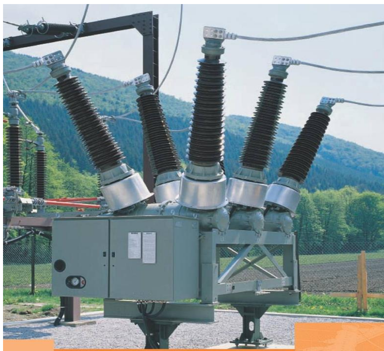
Рисунок 9.2 - Вимикач елегазовий баковий ЗАР1 DT
