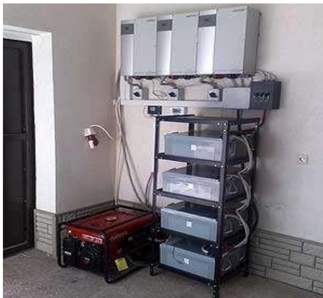
Рисунок 9.8 – Гелеві акумуляторні батареї напругою 12 В
