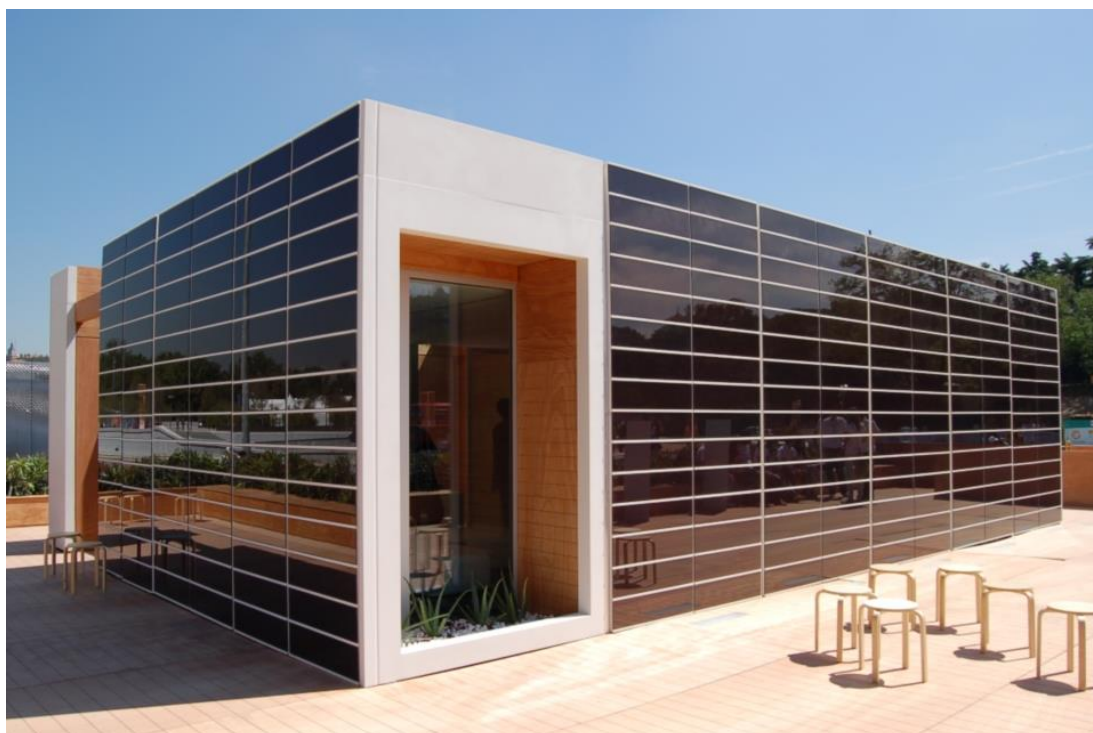
Рисунок 3.5 - Сонячна електростанція BIPV
