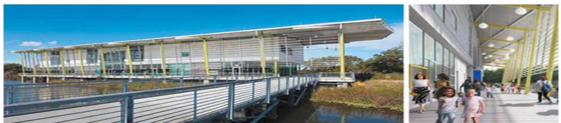
Рисунок 1.5 – Аналіз життєвого циклу будівлі Дитячого музею Луїзіани, США показав недоліки цементу і переваги використання сталі та деревини замість бетону, що і було застосовано у будівлі (проект бюро Mithun), 2019 р
