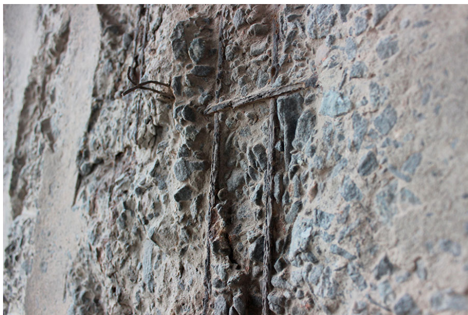
Рисунок 2.1 – Стіна з бетону та залізобетону
