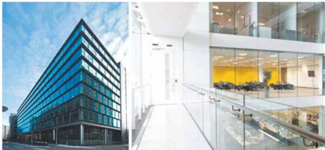
Рисунок 1.3 – Офісна будівля із сталевим каркасом «One Kingdom Street» (м.Лондон, ВБ)
