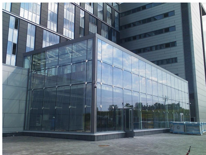
Рисунок 3.3 — Скляні світлопрозорі фасади
