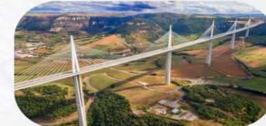
Мілло Віадук (Millau Viaduct), Франція
