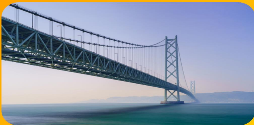
(загальний вигляд сучасної мостової споруди)
