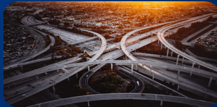
(загальний вигляд сучасного шляхопроводу)
