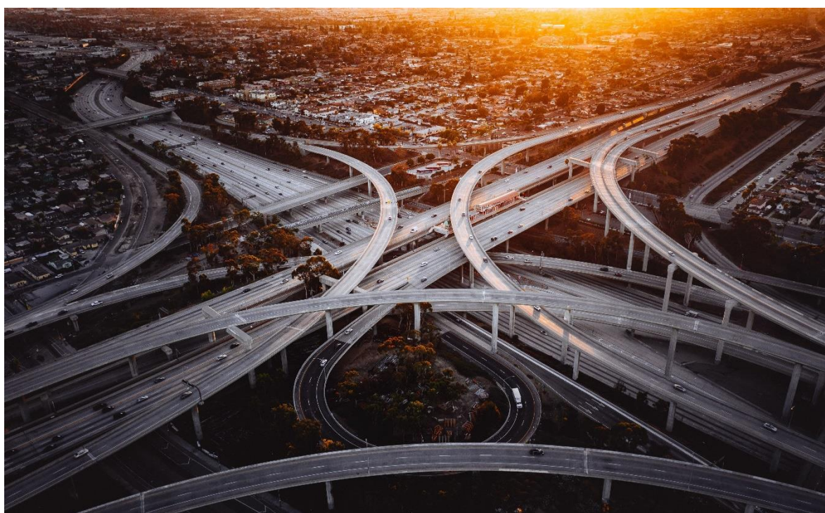
Рисунок 1.2 – Загальний вигляд шляхопроводу
