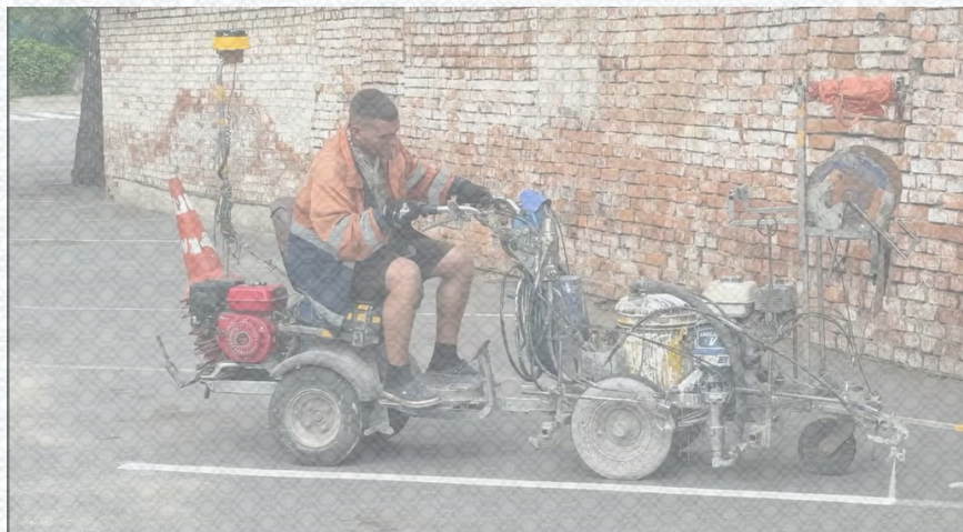
Рисунок 3.3 - Машиніст наносить пряму лінію дорожньої розмітки
