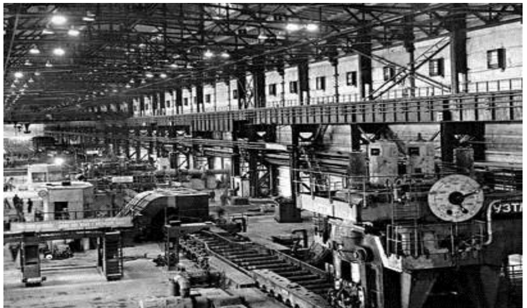
Рисунок 3.2 – Загальний вигляд обладнання прокатного стану
