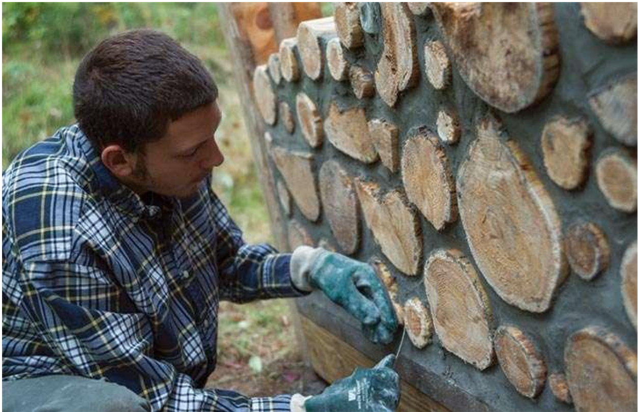
Рисунок 1.2 Стінова конструкція з кордового дерева
