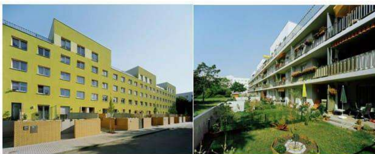
Рисунок 1.3 - Реконструкція житлового будинку м. Галле (Халле)
