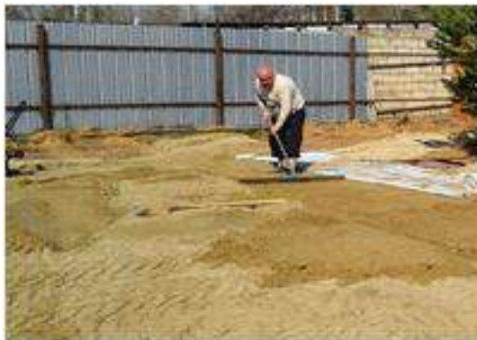
Рисунок 4.8 – Планування площі парковки за допомогою піску
