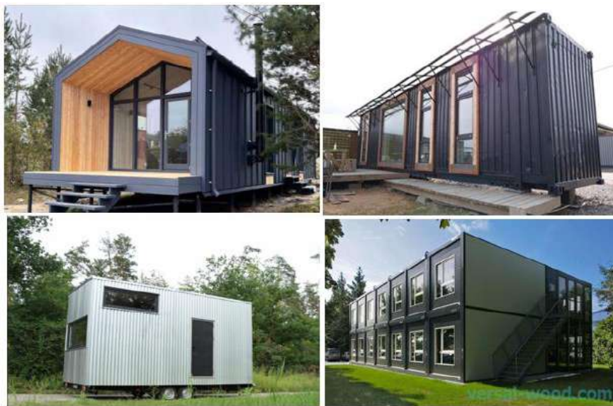
Рисунок 2.2 – Модульний будинок на основі металевого каркасу
