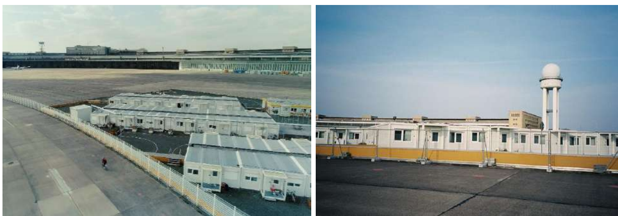
Рисунок 1.5 – Контейнерне містечко «Tempohome Villages»
