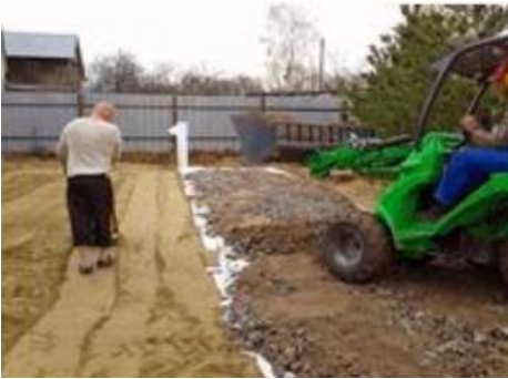
5 - влаштування покриття з гравійного щебеню
