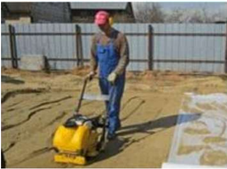
3 - ущільнення ущільнення піщаного шару віброплитою з поливом водою
