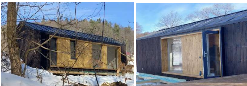
Рисунок 1.23 – Модульний будинок зведений у Луцьку
