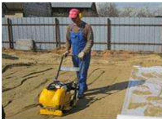
Рисунок 4.9 – Трамбування піщаної подушки
