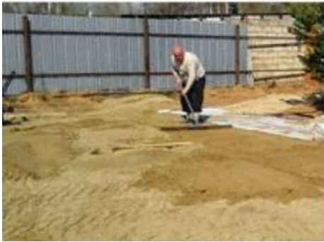
2 - розподіл та планування піщаного шару будівельниками
