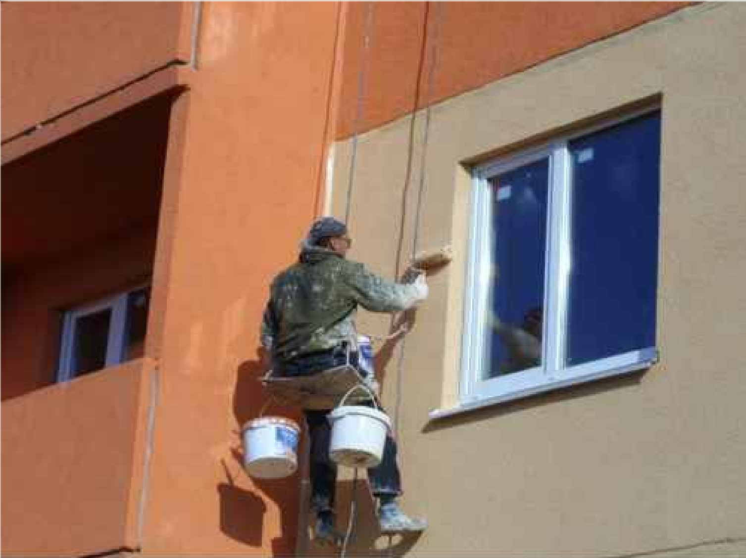
Фарбування стін з використанням валика
