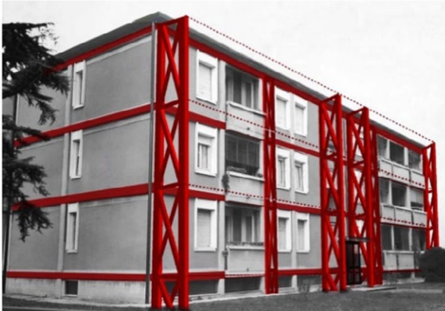
Рисунок 1.17 – Приклад підвищення сейсмостійкості конструкцій із застосуванням додаткових (підведених) конструкцій за технологією «екзоскелета» [26]
