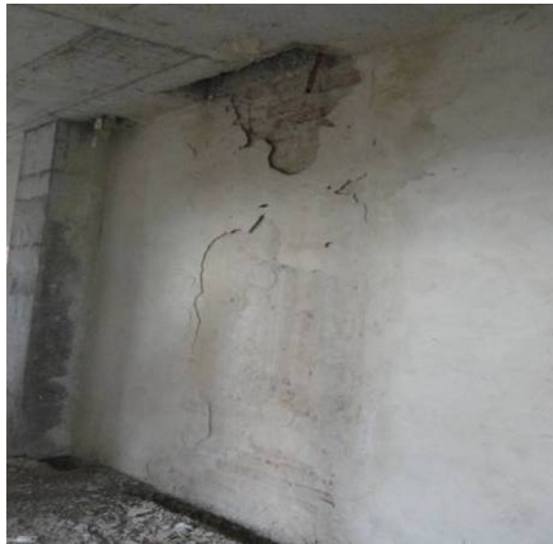
Рисунок 3.18 - Замокання конструкцій
