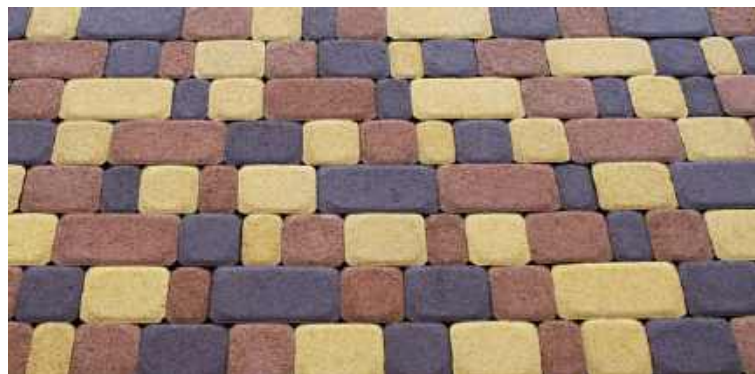
Рисунок 4.3 – Хаотична схема укладання тротуарної плитки
