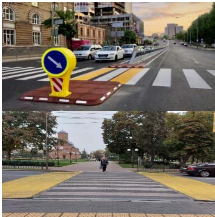
Рисунок 1.10 – Тактильна плитка зупиняючої дії, м. Київ
