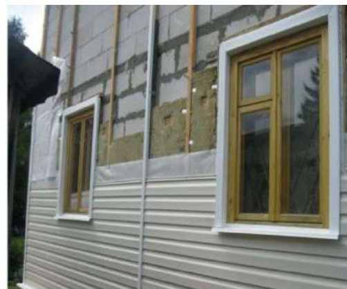
Рисунок 3.2 – Зовнішнє утеплення стін з вентиляльованим прошарком
