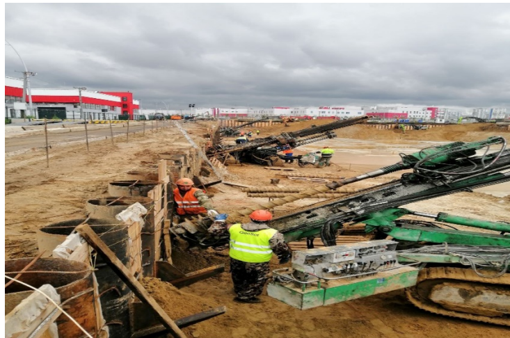
Рисунок 1.7 – Зміцнення ґрунтів ін'єктуванням
