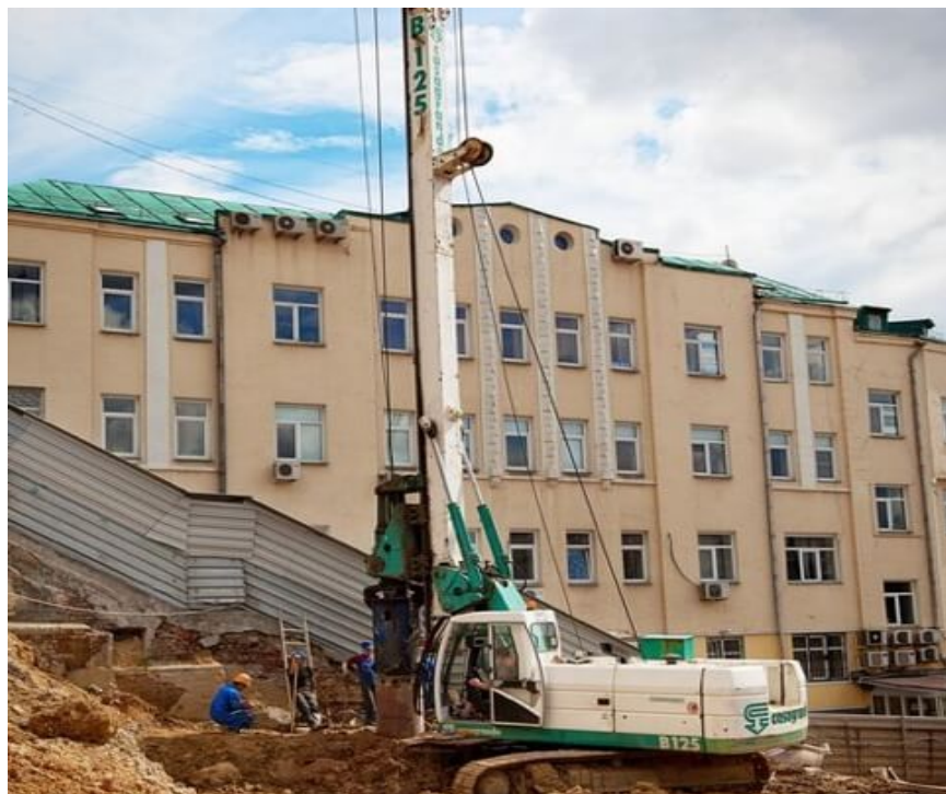
Рисунок 1.6 – Устаткування для зміцнення ґрунтів ін'єктуванням
