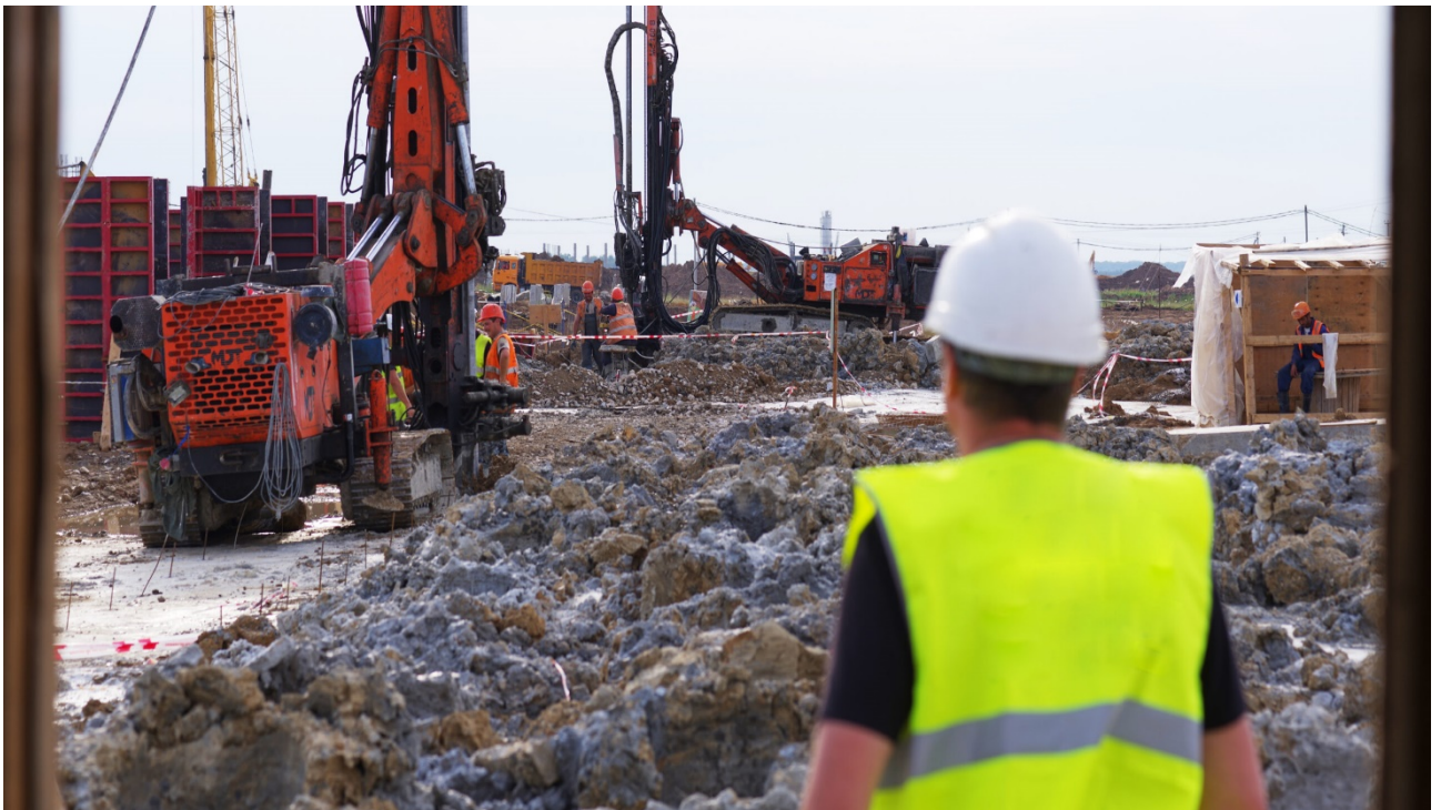
Рисунок 1.5 – Зміцнення ґрунтів ін'єктуванням.
