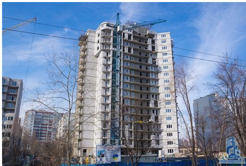
Рис. 4.3. Загальний вигляд будинку, що зводився
