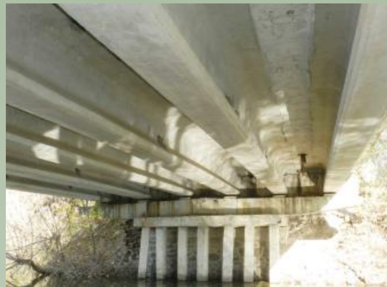
Рис. 4.4 – Загальний вигляд прогонової будови з збірних Т-подібних залізобетонних балок в осях «1-3» та опори по осі «1»
