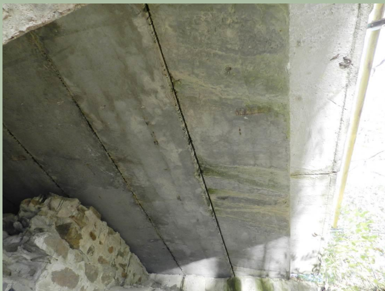
Рис. 4.3 – Загальний вигляд прогонової будови з збірних суцільних залізобетонних плит прямокутного перерізу в осях «0-1»
