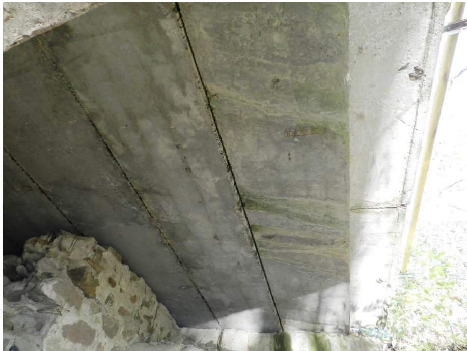
Рисунок 4.3 – Загальний вигляд прогонової будови з збірних суцільних залізобетонних плит прямокутного перерізу в осях «0-1»
