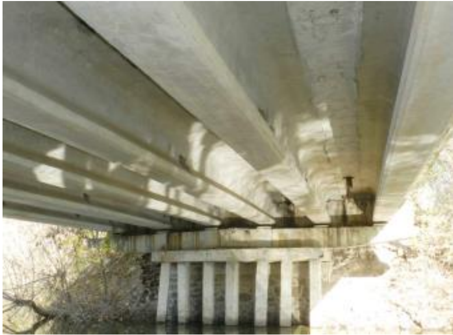
Рисунок 4.4 – Загальний вигляд прогонової будови з збірних Т-подібних залізобетонних балок в осях «1-3» та опори по осі «1»
