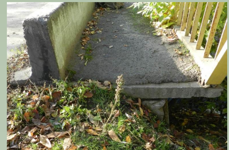
Рис. 4.8 – Загальний вигляд тротуарної плити по осі «Б» поблизу осі «0»
