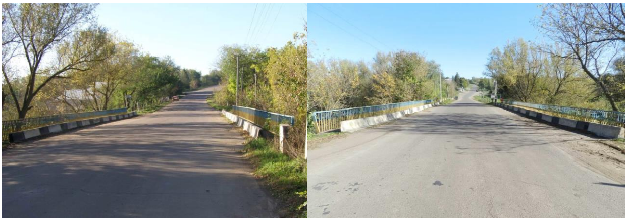
Рисунок 4.2 – Загальний вигляд проїзної частини, тротуарів та підходу зі сторони берегових опор «0» та «4»
