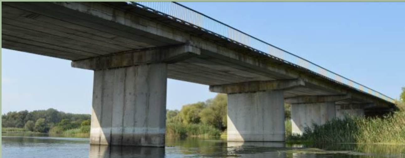
Рис. 1.3 – Загальний вигляд моста через р. Сіверський Донець, м. Чугуїв
