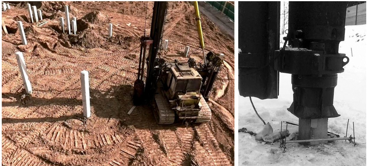
Рис. 1.2 Динамічні випробування палей
