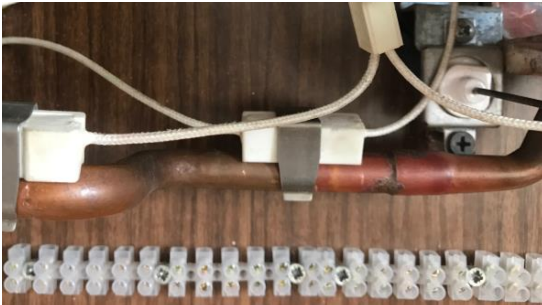
Рисунок 6.6 – Зовнішній вигляд фрагмента лабораторного стенда з клемними затискачами для приєднання пристрою керування
