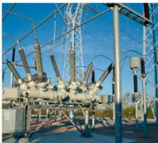
Комірка з двома вимикачами, Італія
