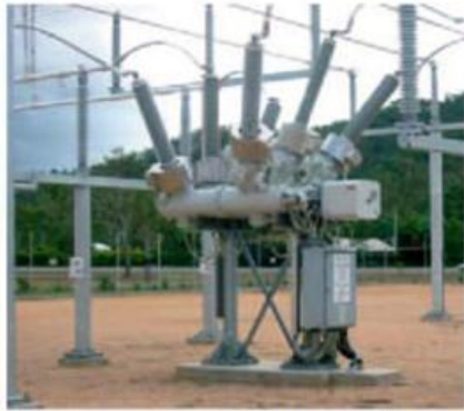
Комірка з одною системою шин, Австралія
