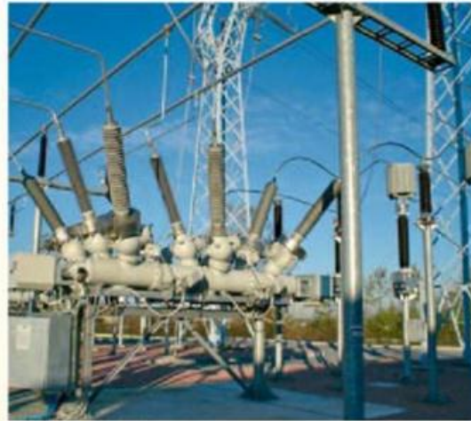
Комірка з двома вимикачами, Італія
