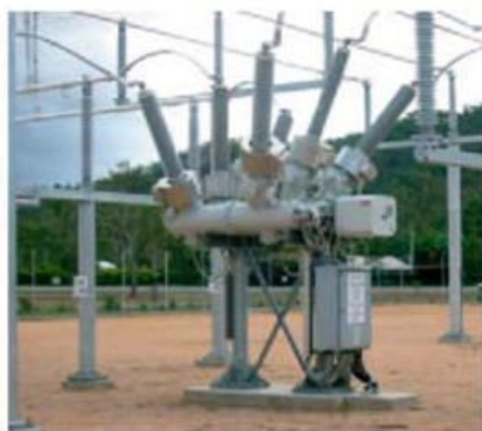
Комірка з одною системою шин, Австралія
