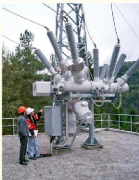
Комірка з двома системами шин, Норвегія
