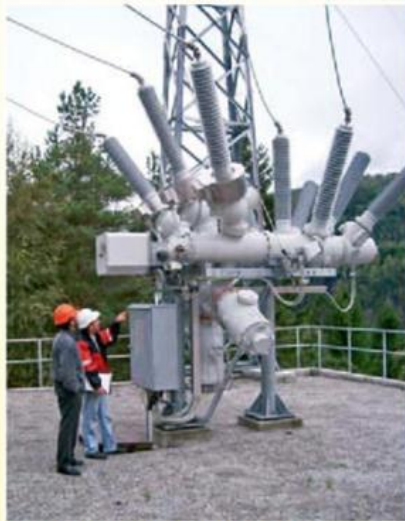
Комірка з двома системами шин, Норвегія
