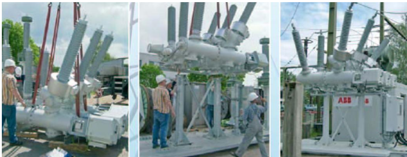
Рисунок 3.5 – Зовнішній вигляд КРУЕ серії PASS
