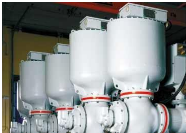
«Класичні» трансформатори напруги і струму в комірці КРУЕ
