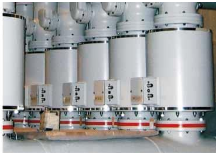
«Класичні» трансформатори напруги і струму в комірці КРУЕ
