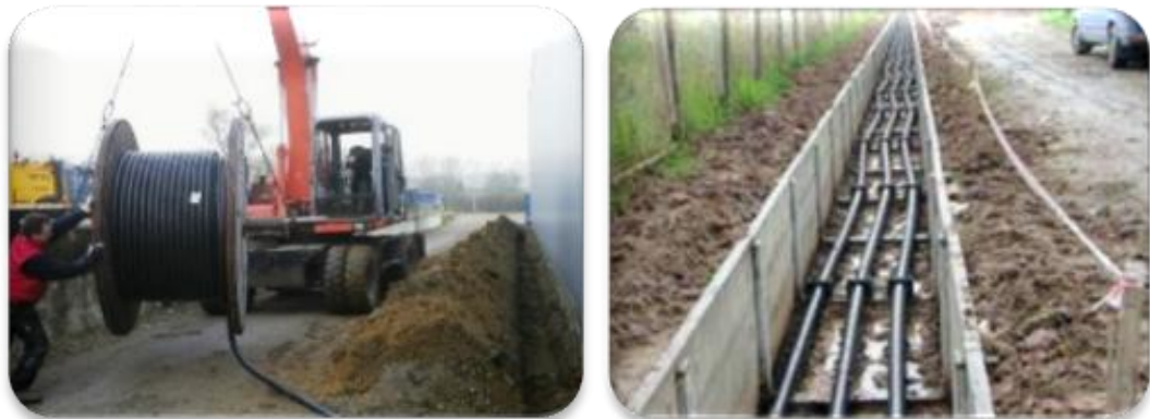
Рисунок 6.1 – Прокладання кабельної лінії
