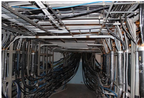
Рисунок 6.8 – Приклад кабельного поверху
