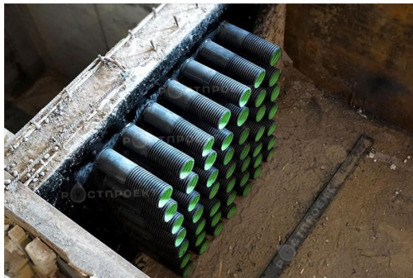
Рисунок 6.7 – Приклад кабельних блоків
