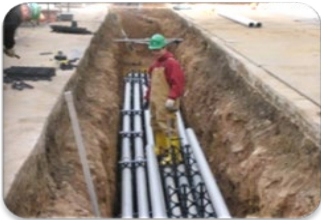
Рис. 5. Маслонаповнена кабельна лінія
