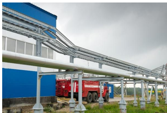
Рисунок 6.11 – Приклад кабельної естакади
