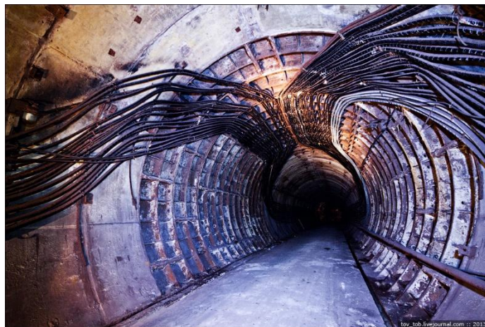
Рисунок 6.5 – Кабельний тунель
