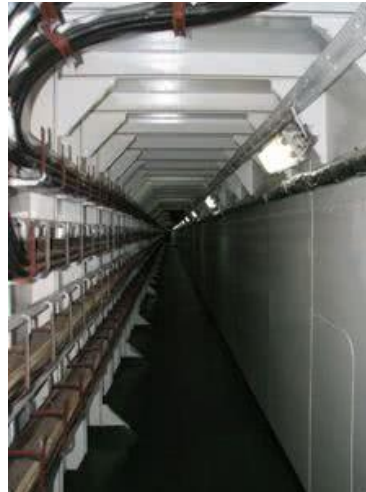
Рисунок 6.10 – Приклад кабельної камери
