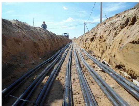
Рисунок 6.4 – Приклад прокладання КЛ в траншеї
