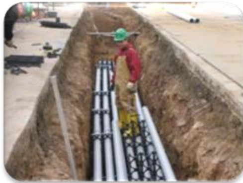
Рис. 6.3. Кабельна лінія заповнена маслом
