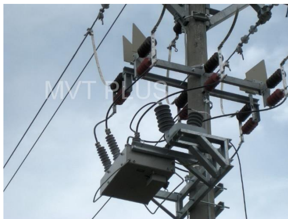
Рис.2.5.1. Реклоузер компанії MVT PLUS
