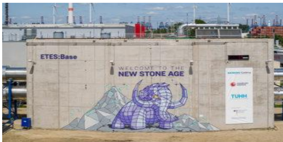
Рисунок 1.15 Система зберігання електричної та теплової енергії
