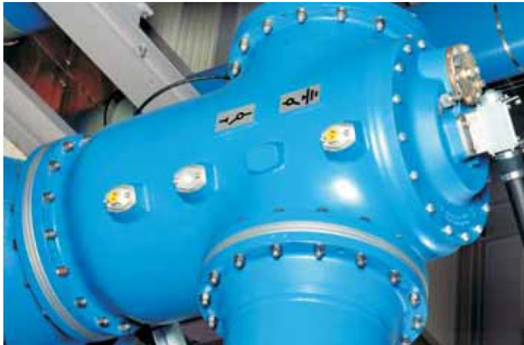
Рисунок 3.13 - Роз'єднувач та заземлювач
