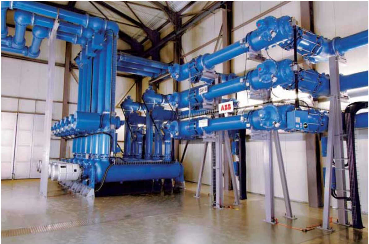
Рисунок 3.6 - Зовнішній вигляд устаткування комплектного розподільного пристрою ELK 3 із одинарною системою збірних шин
