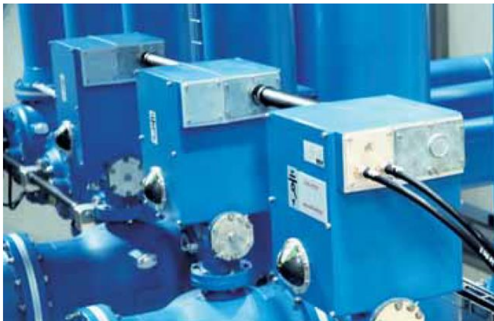
Рисунок 3.14 - Швидкодіючий заземлювач
