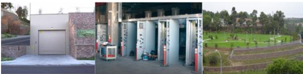
Рис. 2.14 Підземна підстанція Park Above[13]
