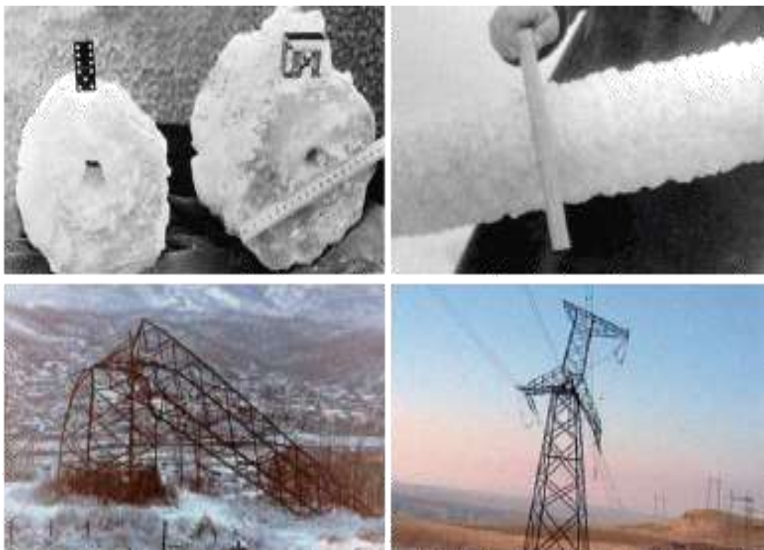
Рисунок 1.9 – Ожеледиця та її наслідки на ПЛ
