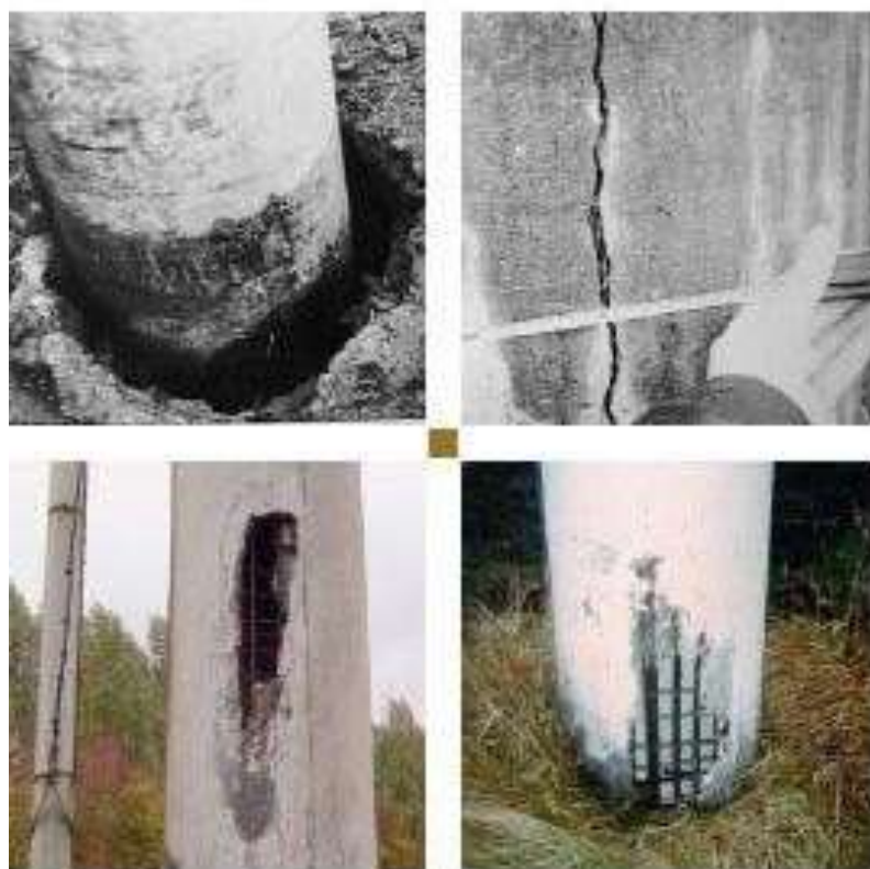
Рисунок 1.4 – Характерні руйнування фундаментів металевих опор
