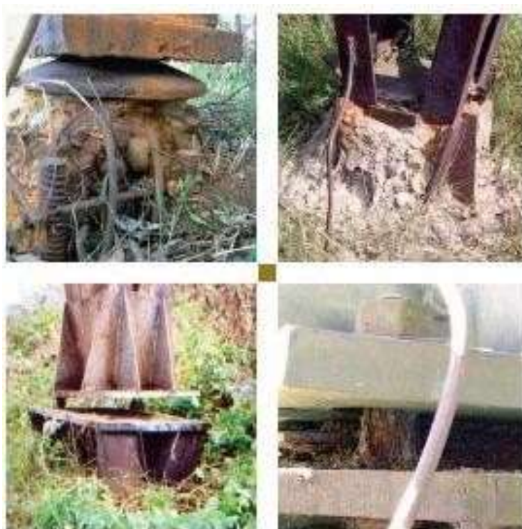
Рисунок 1.4 – Характерні руйнування фундаментів металевих опор
