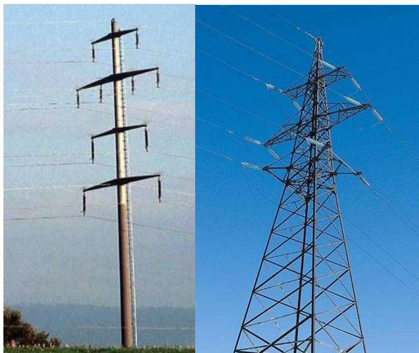
Рисунок 1.1 – Проміжна та анкерна опора
