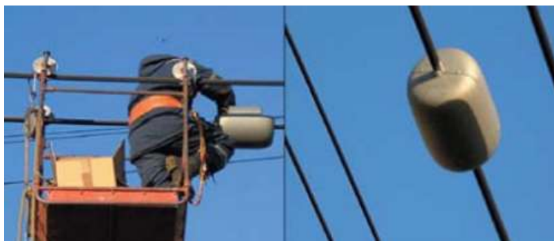
Рисунок 3.10 – монтаж вимірювального блока на проводах ЛЕП
