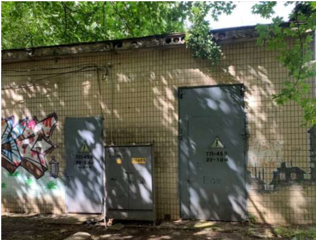
Рисунок 3.3 – Зовнішній вигляд ТП 459, що розташована на території університету
