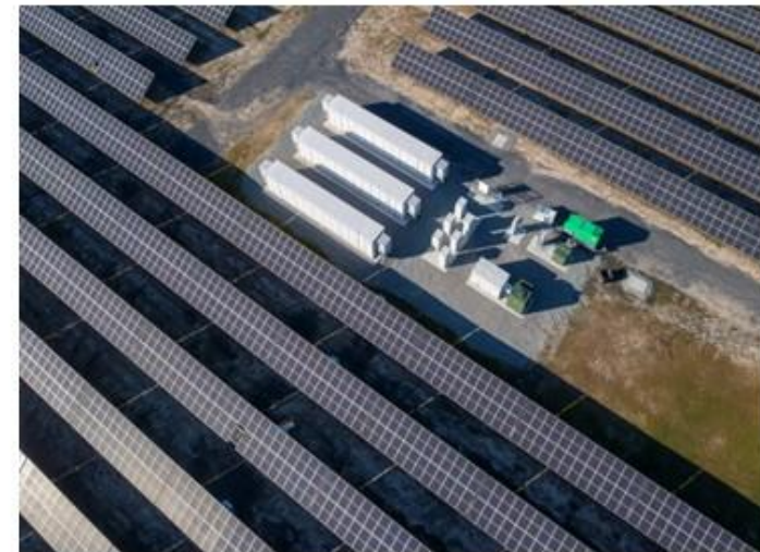
Рисунок 10 - Приклад інтеграції СЕС разом з установкою системи накопичування енергії.
