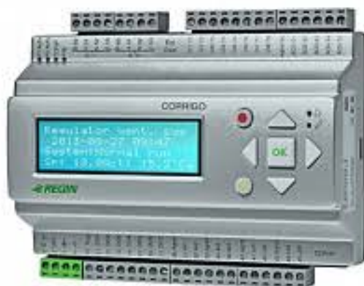
Рисунок 5.5 – Програмований логічний контролер вентиляції типу CORRIGO L-10
