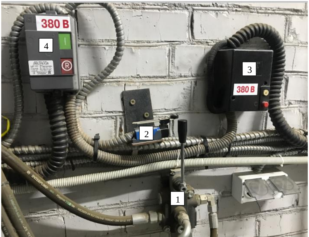
Рисунок 2.5 – Існуючої системи керування підйомником
