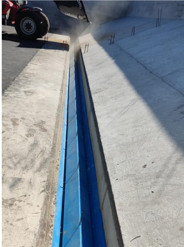
Рисунок 2.2 – Скребокний транспортер площадки розвантаження
