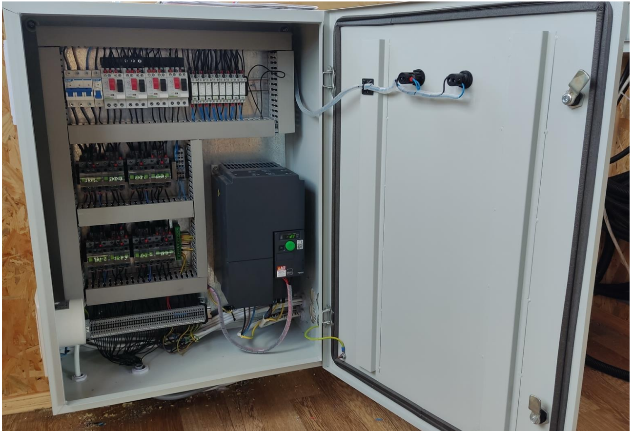
Рисунок 3.17 – Зовнішній вигляд додаткового щита керування
