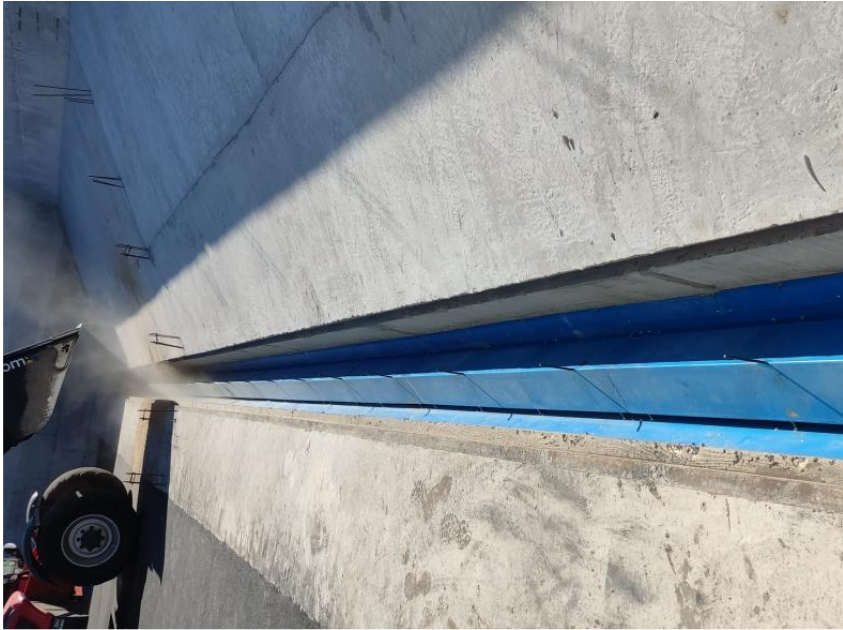
Скребокый транспортер завальной ями (площадки розвантаження)
