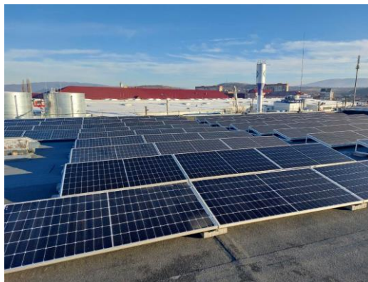
Рисунок 1.8 – Баластна система кріплення для пласких дахів.
