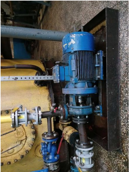
Зовнішній вигляд насоса для перекачування олії в умовах «Гідроаводу» ПрАТ «Вінницький олійножировий комбінат»
