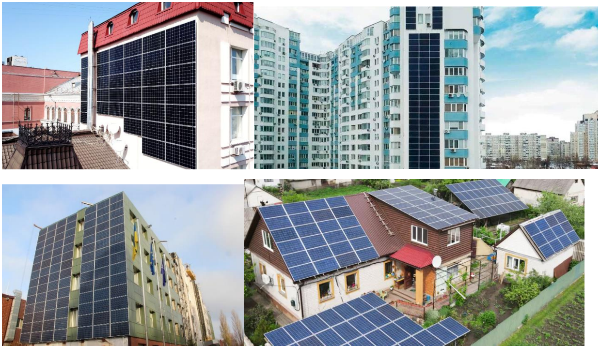
Рисунок 1.4 - Варіанти встановлення сонячних панелей на фасадах та дахах будинків [15]
