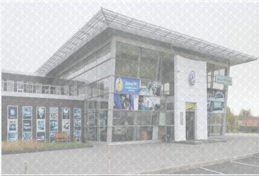
Рисунок 1.1 – Загальний вигляд будинку автоцентру
