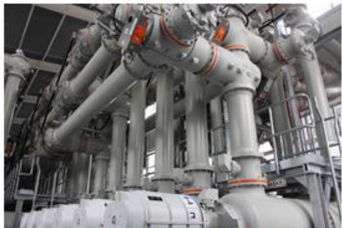
Вигляд з середини КРПЕ ДГЕС з вимикачем ELK-SP3
