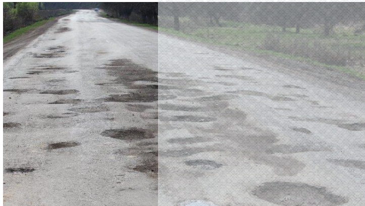
Фрагмент дороги зі зруйнованою поверхнею
