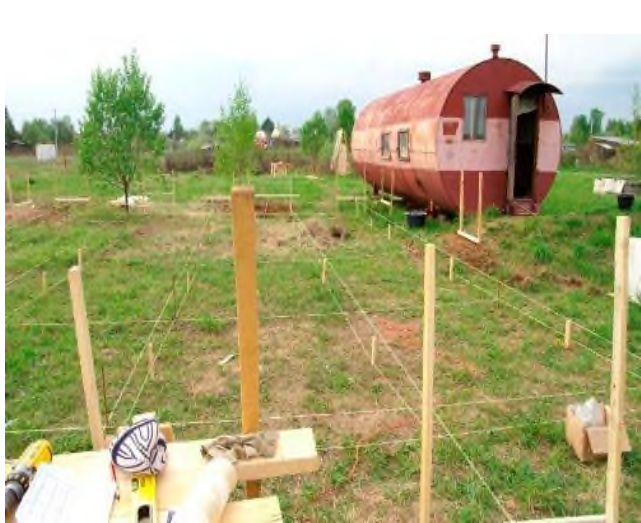
1. Розмітка території під фундамент
