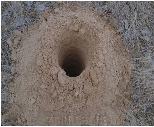
2. Розробка ґрунту під фундамент
