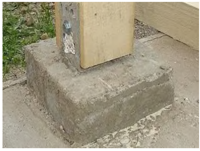
4. Бетонування з влаштуванням кліплення під колони
