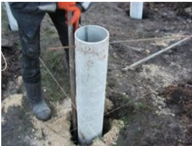
3. Встановлення азбестоцементних труб під фундамент
