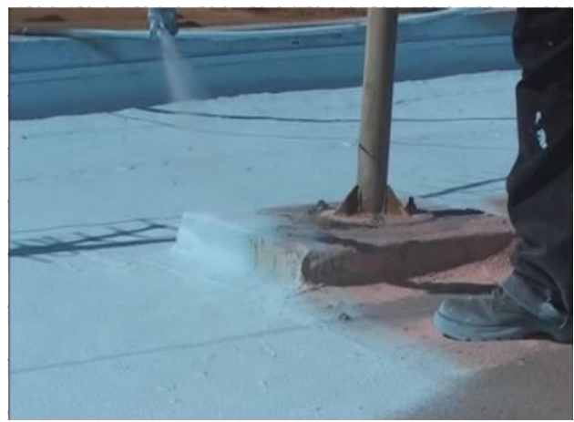
Грунтування поверхні
