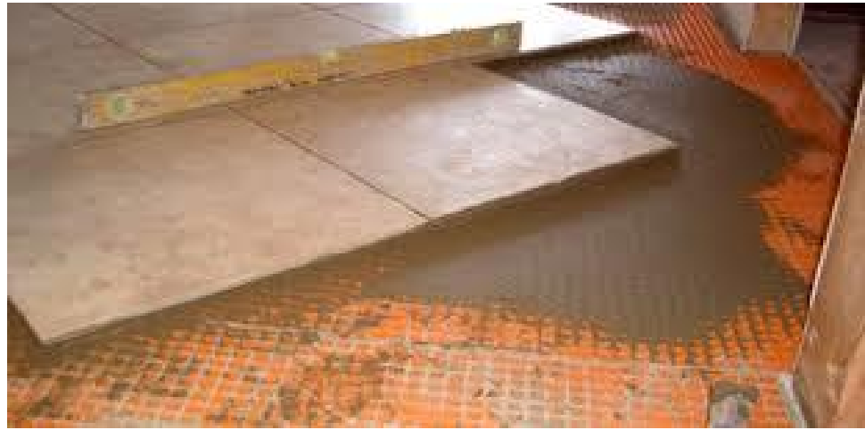
Наклеювання облицювальної плитки
