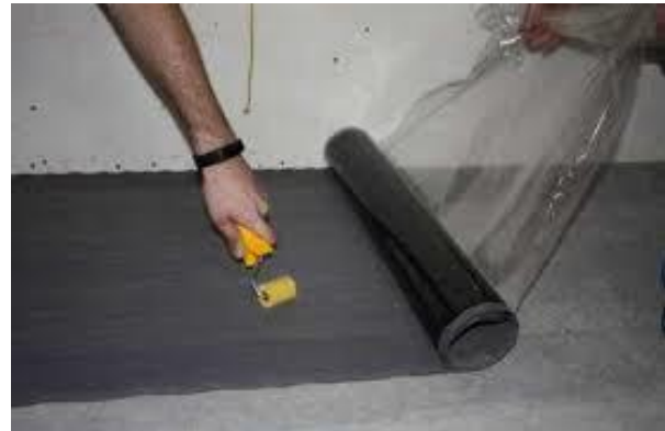
Влаштування гідроізоляції
