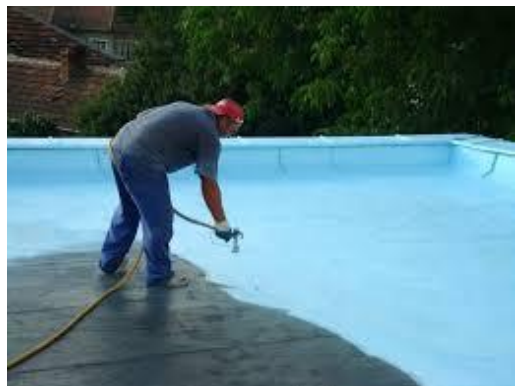
Грунтування поверхні
