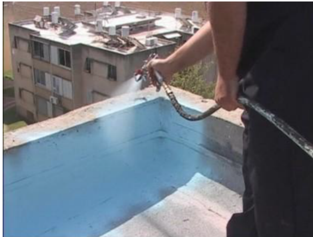
Нанесення мастики на місця примикань мастичного покрівельного килима до парпетів
