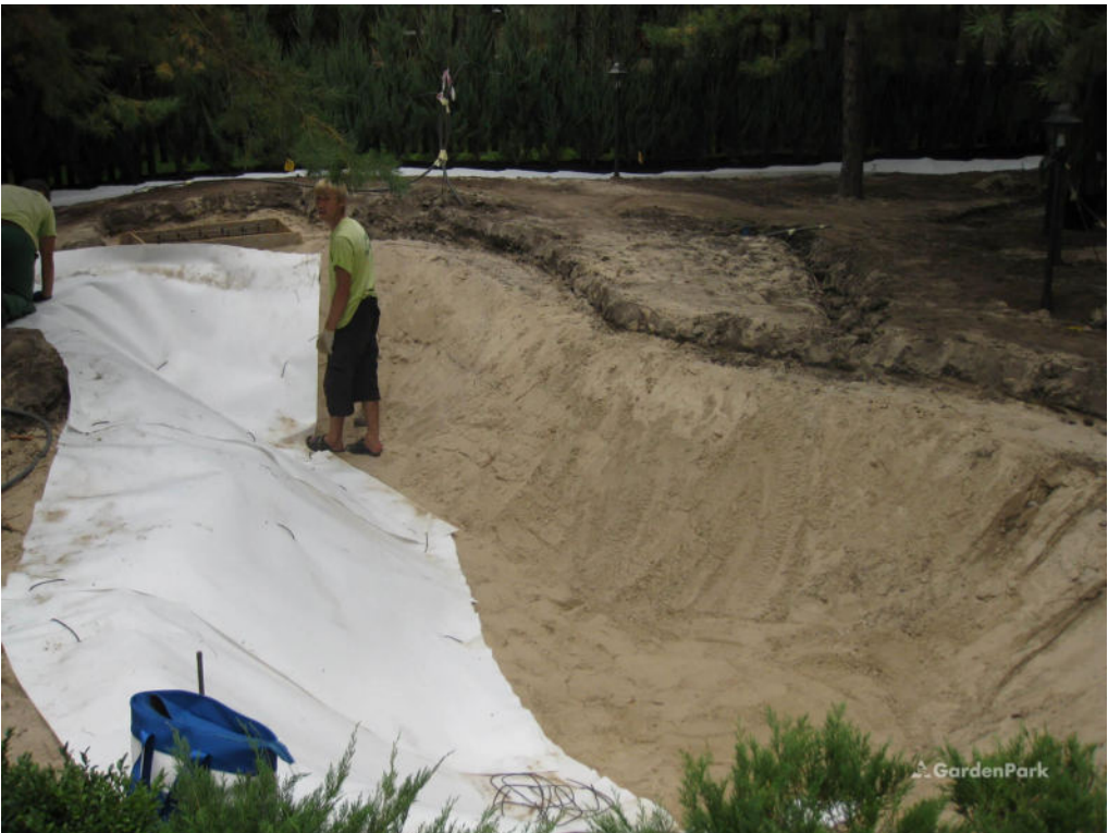
2 РОЗСТИПАННЯ ПОЛОТЕН ПЛІВКИ ПВХ
