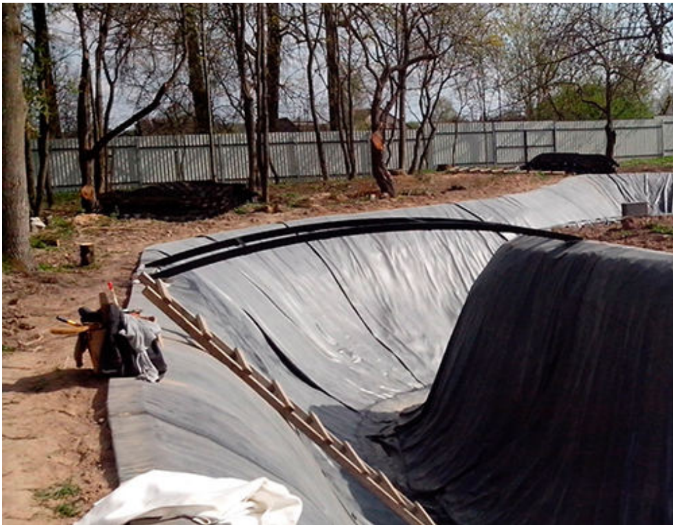
3 ОБРОБКА КРАЇВ ПЛІВКИ ПО ПЕРИМЕТРУ ВОДОЙМИ
