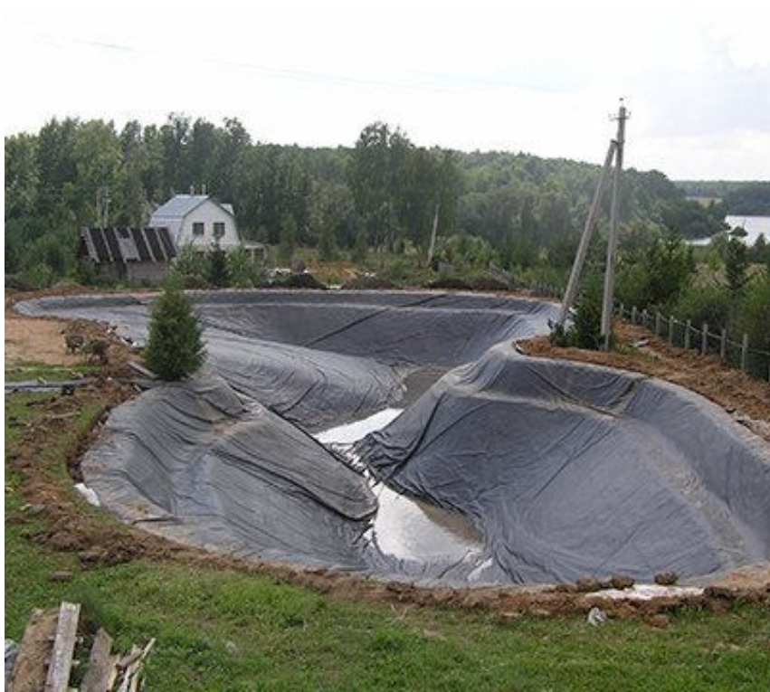
5 УПАШТУВАННЯ ЗАХОСНОГО ШАРУ НА УКОСАХ
