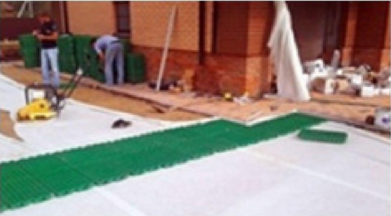
4 ВПЛАШТУВАННЯ ГАЗОННИХ РЕШІТОК
