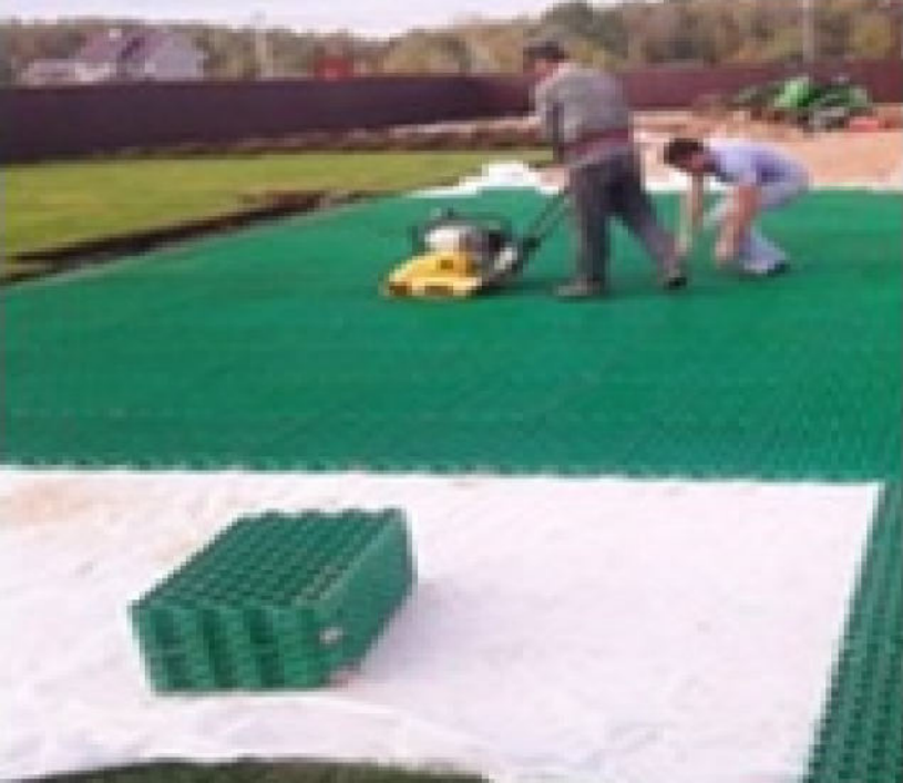
4 ВПЛАШТУВАННЯ ГАЗОННИХ РЕШІТОК
