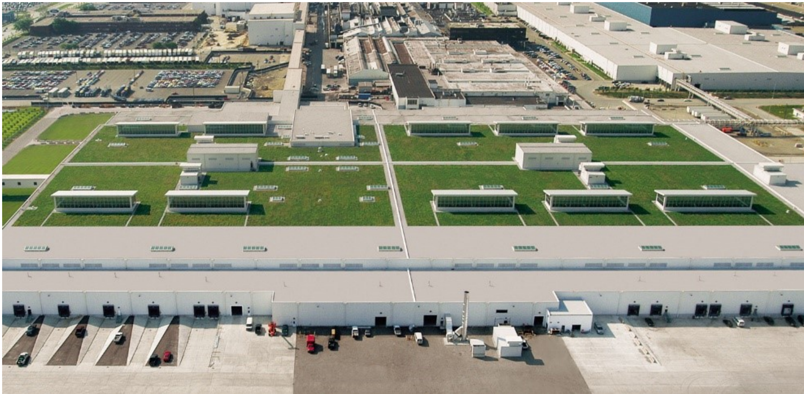
"Зелена" покрівля заводу Ford, Рівер Руж, США
